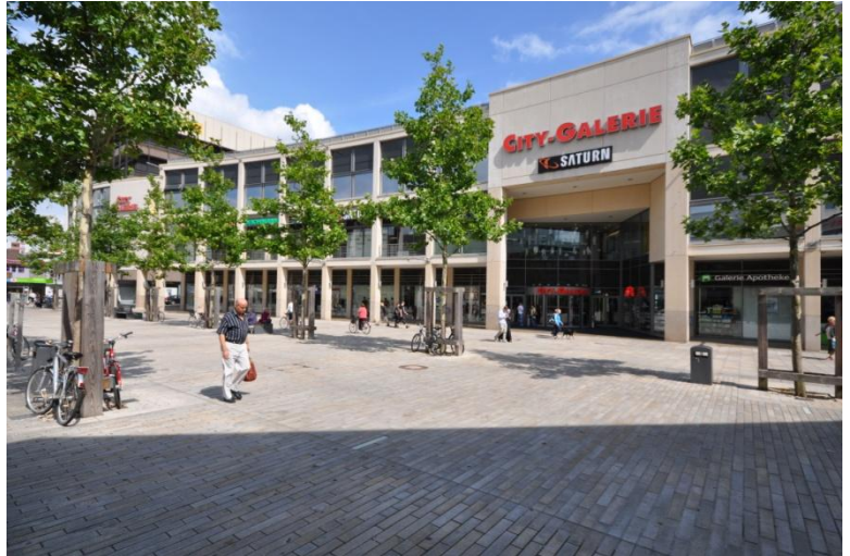
City-Galerie im mittleren Bereich der Porschestraße
